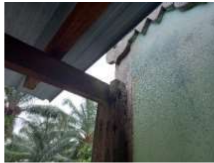
Foto 6: Struktur hubungan tanggam tebuk
