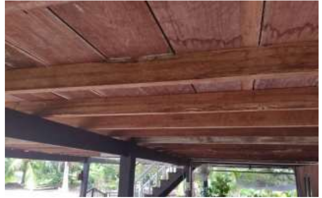
Rajah 6: Struktur Kerangka Lantai
