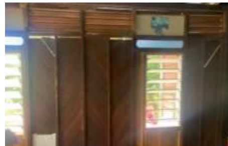
Rajah 9: Kerangka Dinding Utama Dengan Tingkap Ram Tetap di Bahagian Atas
