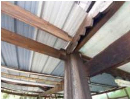
Foto 5: Struktur hubungan tanggam lidah dan alur
