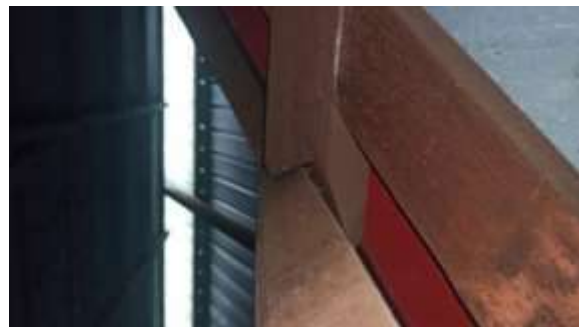
Foto 8 : Struktur Bumbung menggunakan sambungan tanggam
