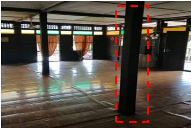
Rajah 3 : Penggunaan Kayu Bagi Tiang, Dinding Dan Papan Lantai
